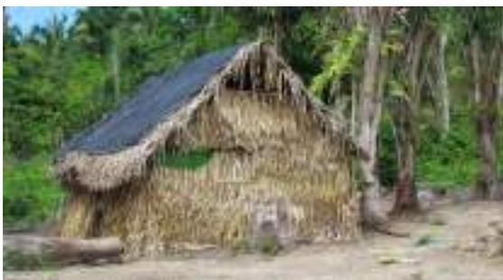
**Foto 09:** Detalhe de casa com cobertura de palha de babaçu (*Attalea flexuosa*), na área do finado Toco (09/8/19).
