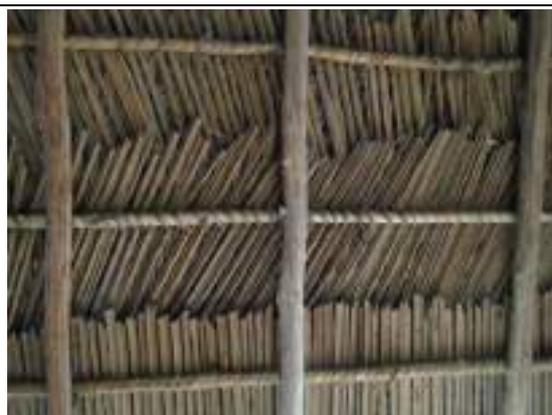
**Foto 41:** Detalhe da cobertura de palha de inajá (*Attalea maripa*) existente na Casa da Cultura do Índio da aldeia Furo Seco (25/4/19).
