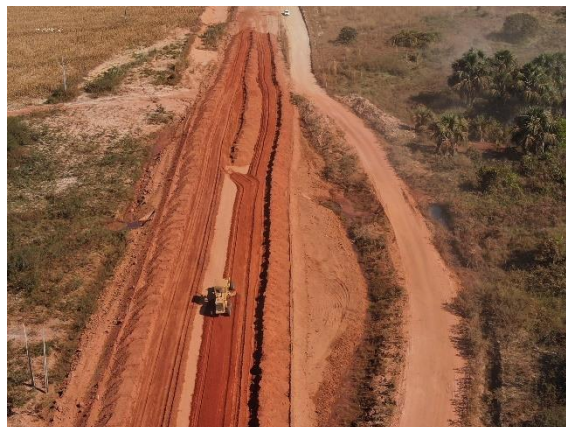
Figura 79. Obras de pavimentação em execução.
