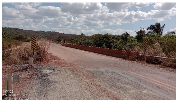
Figura 25. Visão geral da Ponte sobre o Rio Pium.
