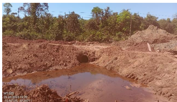
Figura 87. Manilha para transposição de curso d'água pelo caminho de serviço.
