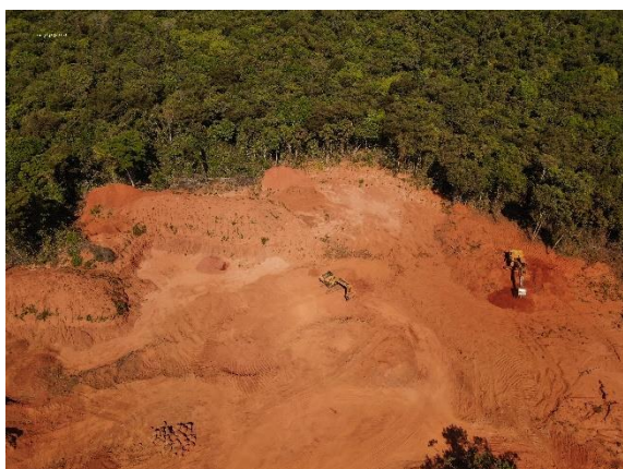
Figura 108. Máquinas em operação para retirada da camada de solo.
