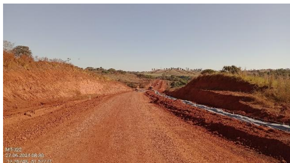
Figura 158. Frente de obra, com implantação de sistema de drenagem.
