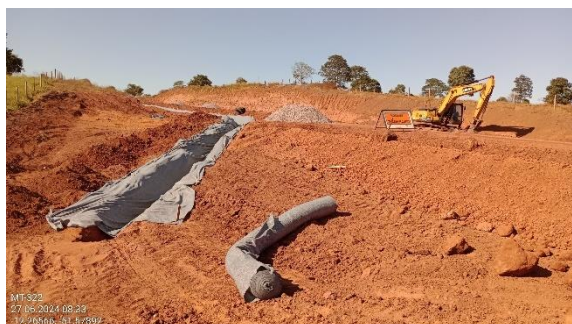
Figura 159. Frente de obra, com implantação de sistema de drenagem.
