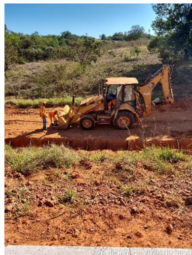
Figura 69. Trabalhadores em frente de obra.
