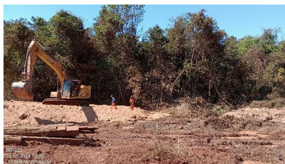
Figura 95. Trabalhadores em frente de obra.
