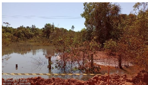
Figura 83. Corpo hídrico a jusante da rodovia.
