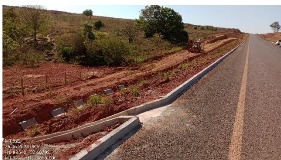
Figura 56. Obras de implantação do sistema de drenagem em execução.
