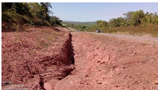
Figura 10. Vala aberta para sistema de drenagem ainda não instalado.
