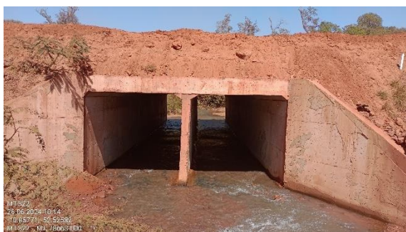
Figura 82. BDCC em trecho em obras.
