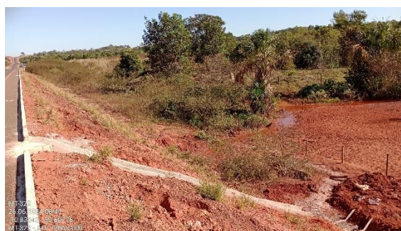
Figura 57. Sistema de drenagem em implantação próximo à curso d'água assoreado e sem APP.
