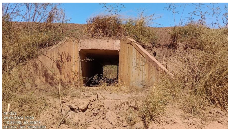
Figura 115. Entrada da Passagem Inferior de Fauna.
