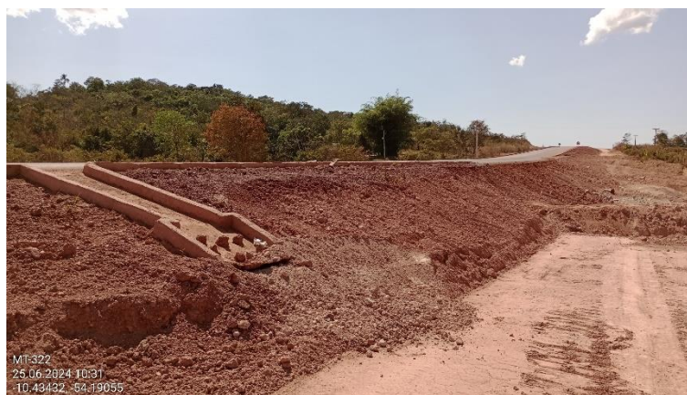
Figura 22. Dispositivo de drenagem com dissipadores de energia (em primeiro plano, à esquerda), e local de obra de correção de OAC (ao fundo, à direita).
