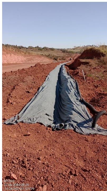
Figura 160. Implantação do sistema de drenagem.
