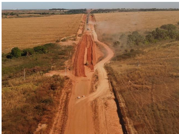
Figura 78. Obras de pavimentação em execução.
