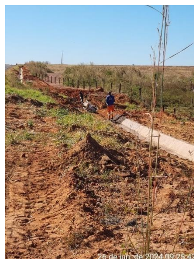
Figura 71. Trabalhadores em frente de obra.
