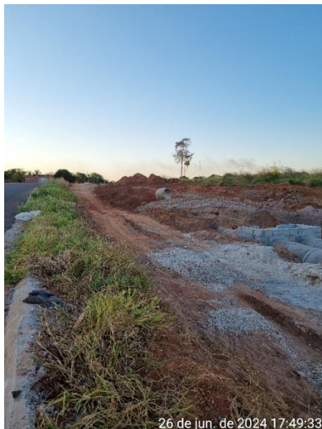
Figura 133. Obras de implantação do sistema de drenagem no início do segmento rodoviário.
