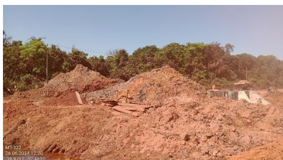
Figura 88. Disposição de resíduos em frente de obra.
