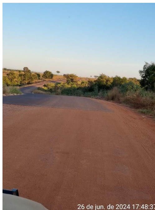
Figura 132. Início do segmento em obras (km 227,47).
