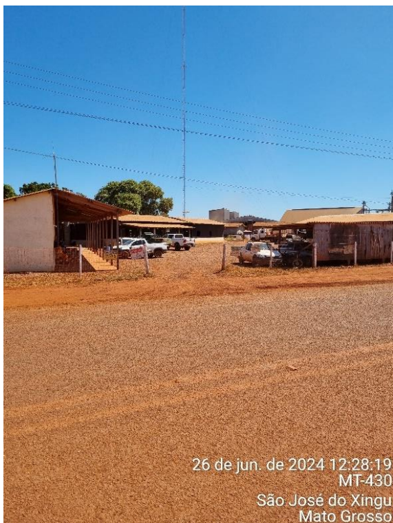
Figura 120. Entrada do canteiro de obras.
