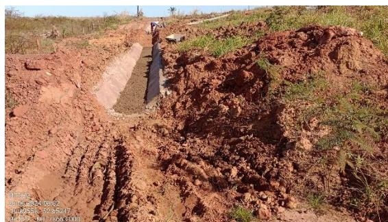
Figura 55. Sistema de drenagem em implantação.
