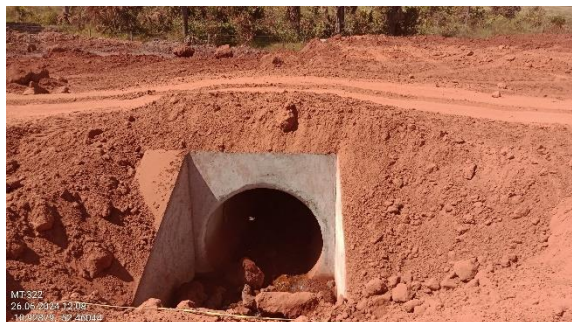
Figura 84. BSTC em trecho em obras.
