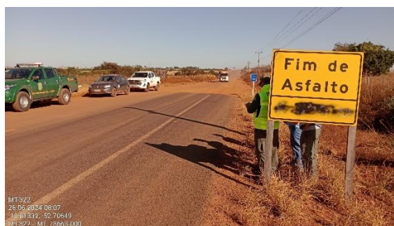
Figura 49. Placa de sinalização.
