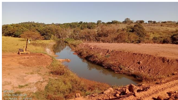
Figura 161. Captação de água superficial para abastecimento de caminhão-pipa.
