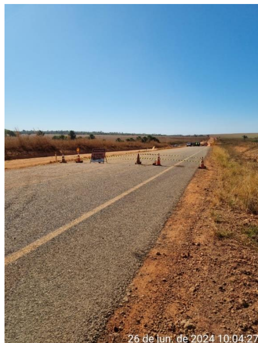
Figura 73. Sinalização do local em obras.
