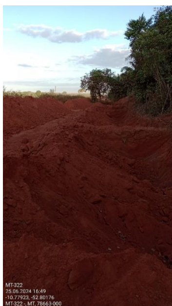
Figura 44. Vala escavada na margem da rodovia não pavimentada.
