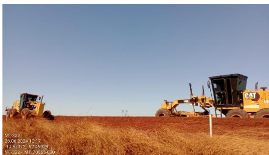
Figura 114. Máquinas em operação executando atividades de terraplanagem.
