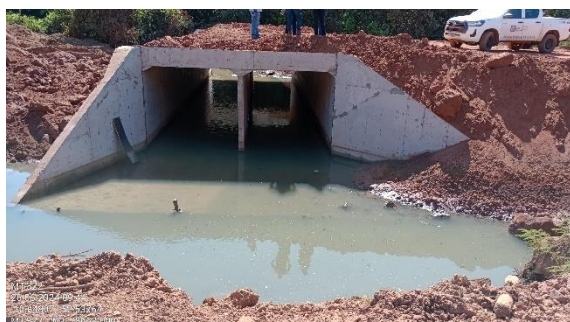
Figura 100. BDCC em trecho em obras.
