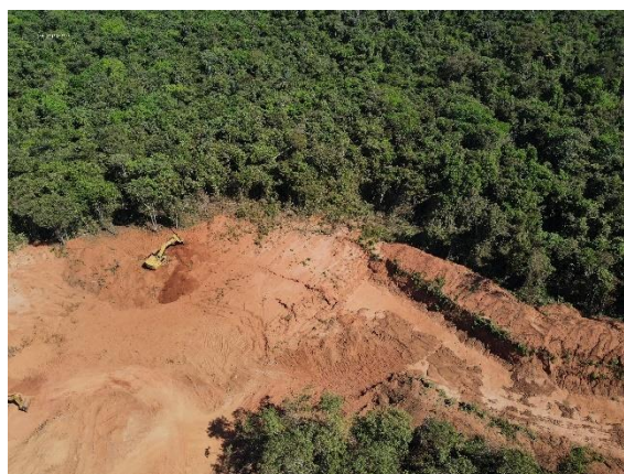
Figura 109. Máquina em operação para a retirada da camada de solo.
