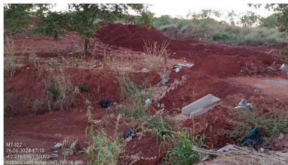
Figura 146. Disposição irregular de resíduos sólidos na faixa de domínio da rodovia, ao lado lixão.
