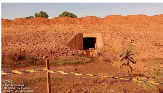
Figura 80. BSCC em trecho em obras.
