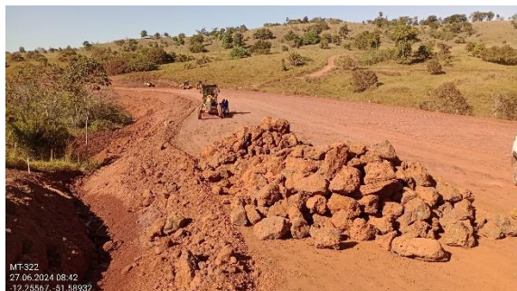
Figura 164. Frente de obra.
