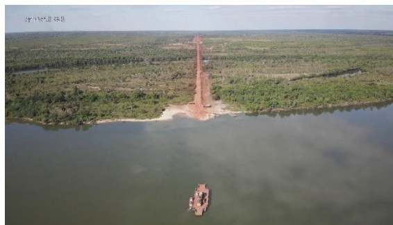
Figura 40. Balsa em deslocamento e margem leste.
