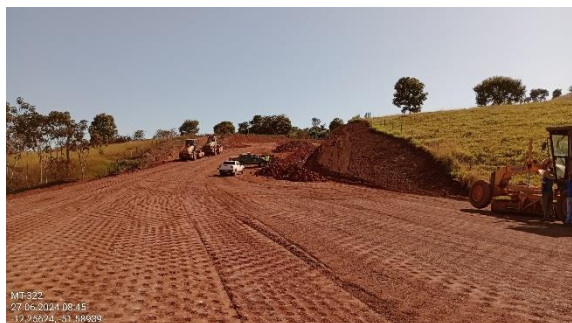
Figura 163. Frente de obra.
