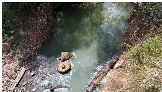
Figura 28. Resíduos de construção civil dispostos irregularmente no leito do curso hídrico, sob a OAE.
