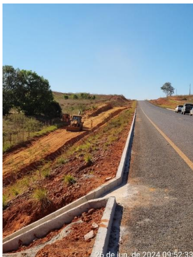
Figura 68. Frente de obra sem estruturas de banheiros químicos e tendas.
