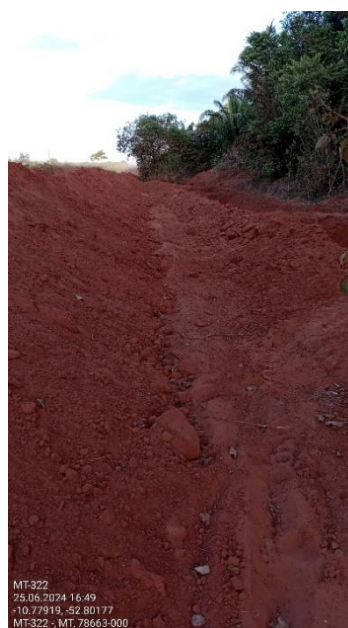
Figura 45. Vala escavada na margem da rodovia não pavimentada.
