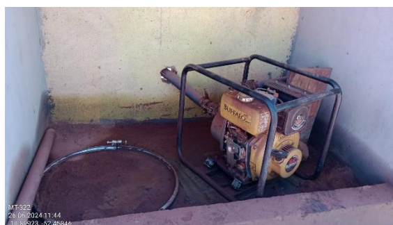
Figura 130. Abertura para a passagem de mangueira.
