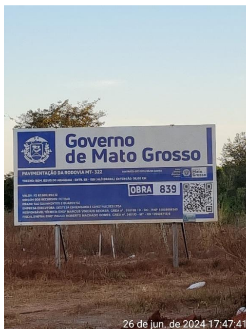
Figura 131. Placa com informações referentes às obras de pavimentação da rodovia MT-322 em Bom Jesus do Araguaia/MT (km 227,47).
