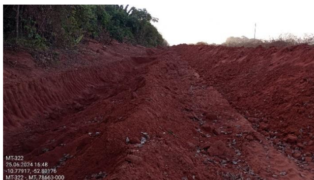
Figura 43. Vala escavada na margem da rodovia não pavimentada.
