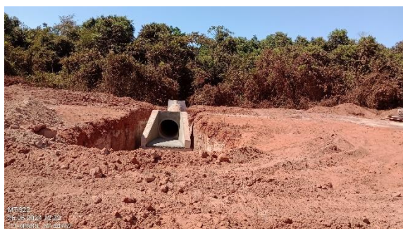
Figura 94. Obras de implantação de BSTC.
