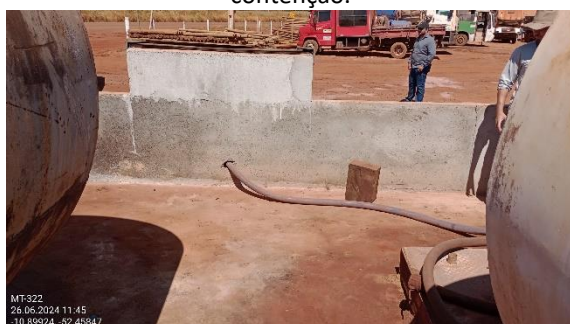
Figura 129. Abertura para a passagem de mangueira.
