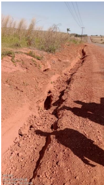
Figura 8. Vala escavada para instalação de sistema de drenagem na margem da rodovia.
