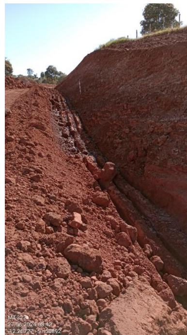
Figura 165. Sistema de drenagem em implantação.
