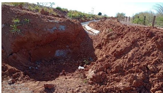
Figura 54. Sistema de drenagem em implantação.
