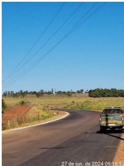
Figura 157. Interação entre linha de transmissão e rodovia.
