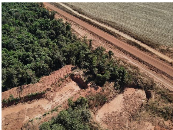
Figura 110. Proximidade da jazida com a Rodovia MT-322.
