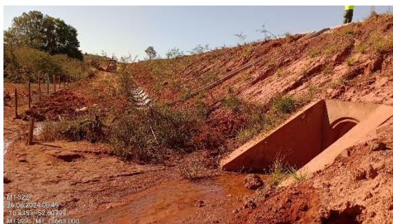
Figura 58. Sistema de drenagem em implantação próximo a curso d'água degradado.
