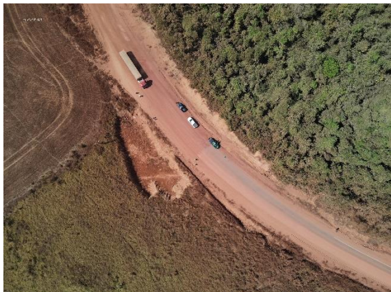
Figura 29. Foto aérea do final do segmento pavimentado e início do segmento não pavimentado e área da antiga jazida (Km 613,37).
