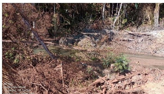
Figura 103. Curso d'água com as margens aterradas e restos vegetais, a jusante da rodovia.
