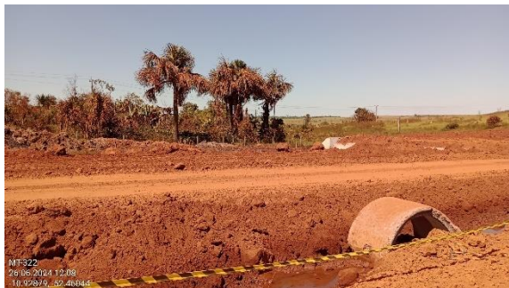
Figura 117. Manilhas dispostas no eixo rodoviário em obras.
