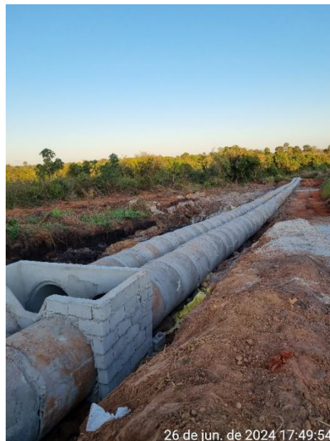
Figura 134. BDTC em implantação.
