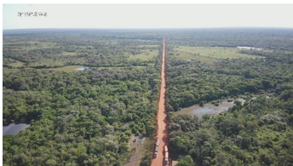
Figura 39. Rodovia MT-322, a partir da margem oeste.
