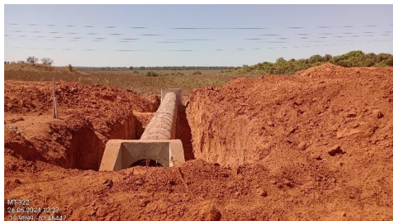
Figura 92. Obras de implantação de BSTC.
