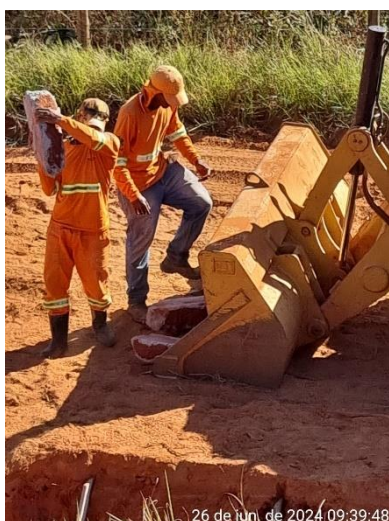
Figura 70. Trabalhadores em frente de obra.
