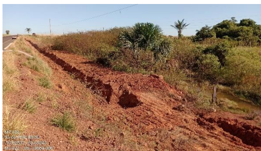
Figura 53. Vala escavada para sistema de drenagem em implantação.
