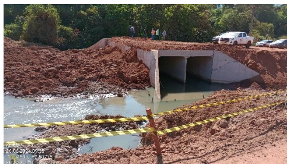
Figura 99. BDCC em trecho em obras.
