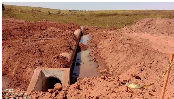
Figura 85. BSTC em trecho em obras.
