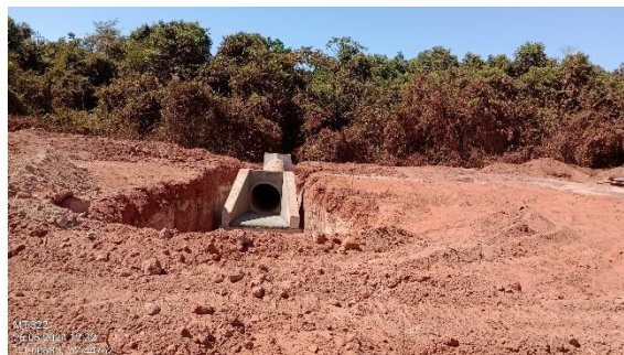
Figura 93. Obras de implantação de BSTC.
