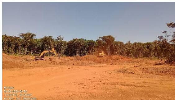
Figura 113. Máquinas em operação para a retirada da camada de terra.
