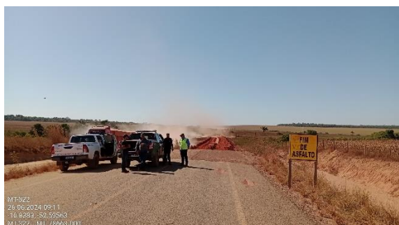
Figura 74. Fim do trecho com pavimentação concluída e início do trecho não pavimentado com obras em execução.
