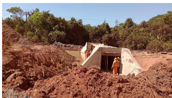
Figura 89. Obras de implantação de BSCC.
