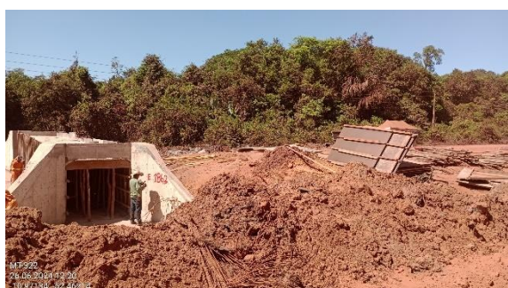
Figura 90. Obras de implantação BSCC e disposição de resíduos (à direita).
