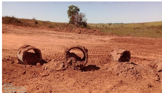
Figura 118. Manilhas dispostas no eixo rodoviário em obras.
