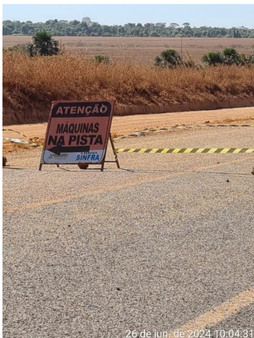
Figura 72. Sinalização do local em obras.
