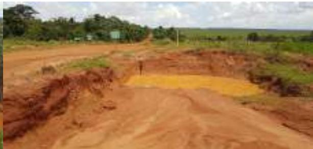
Figura 38 – Caixa de decantação na margem esquerda da rodovia.
