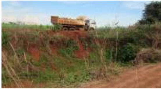
Figura 27 - Caixa de empréstimo, na margem direita da rodovia.
