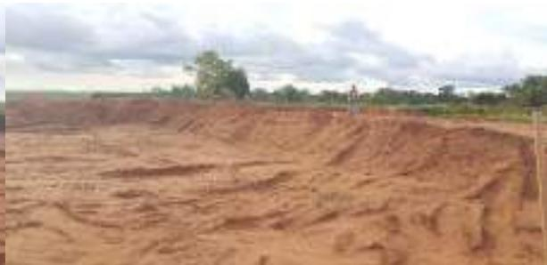
Figura 40 – Bacia de decantação na margem esquerda da rodovia.
