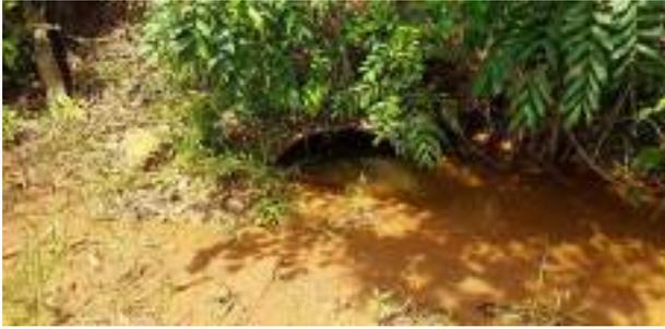
Figura 53 – Trecho da rodovia, detalhes de processos de assoreamento. Córrego tributário do Rio Jatobá.
