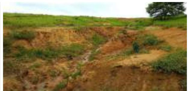
Figura 60 – Vista parcial de parte do traçado da rodovia, detalhes de processos erosivos. Áreas próxima do Rio Jatobá, este local foi usado como caixa de empréstimo.
