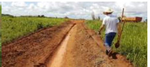
Figura 34 - Vala de drenagem na margem esquerda da rodovia.
