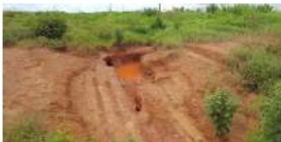
Figura 33 - Vala de drenagem na margem esquerda da rodovia.
