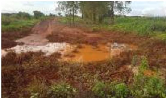
Figura 31 - Vala de drenagem e caixa de decantação na margem esquerda da rodovia.
