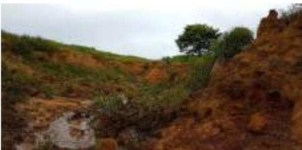
Figura 59 – Vista parcial de parte do traçado da rodovia, detalhes de processos erosivos. Áreas próxima do Rio Jatobá, este local foi usado como caixa de empréstimo.
