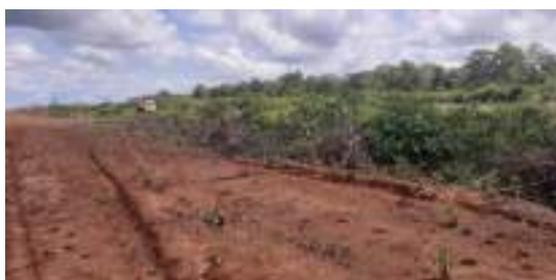
Figura 23 - Caixa de empréstimo, na margem direita da rodovia.
