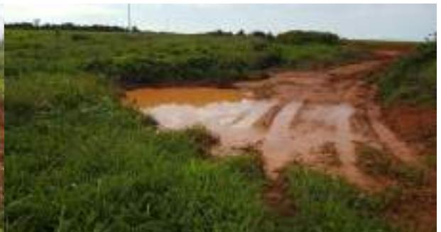
Figura 32 - Vala de drenagem e caixa de decantação na margem esquerda da rodovia.
