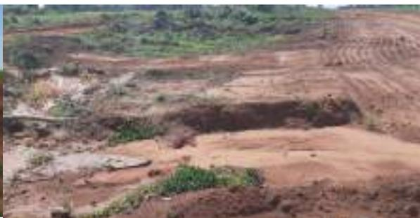
Figura 22- Caixa de empréstimo, na margem direita da rodovia (fotografia de Drone).
