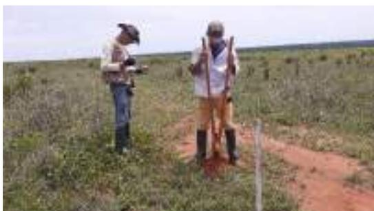
Figura 75 – Atividade perspectiva, detalhes do estaqueamento da rodovia, área de pastagem. Ponto 215, faixa central do traçado da rodovia.
