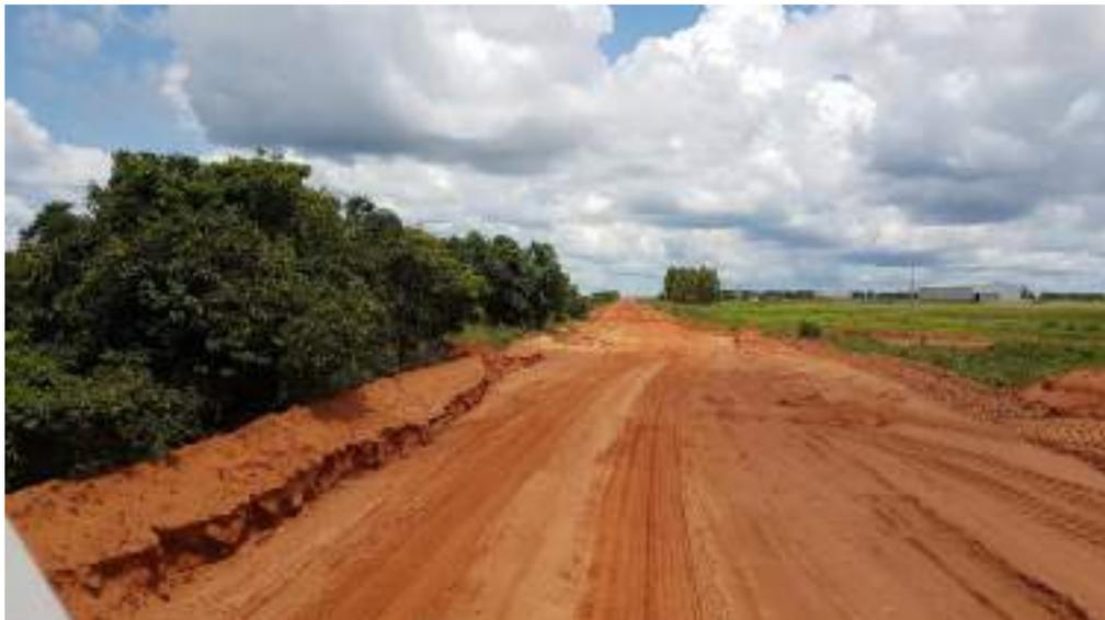
Figura 7 - Vista parcial de parte do trecho 1 da rodovia já existente, restando apenas o asfaltamento.
