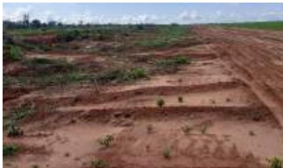
Figura 29 - Caixa de empréstimo, na margem direita da rodovia.
