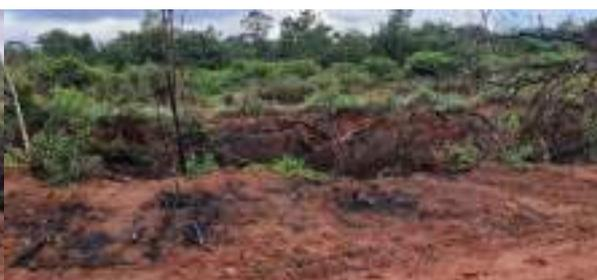
Figura 24 - Caixa de empréstimo, na margem direita da rodovia.
