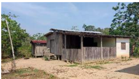
FIGURA 145 CASA DE UTILIZADA COMO ESCOLA, ALDEIA KRAMBARJ, EM 09/10/2023.
