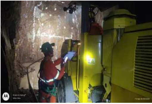
FIGURA 5 PREPARAÇÃO DE DETONAÇÃO.
