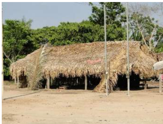
FIGURA 202 TELHADO FEITO COM FOLHAS DE BABAÇU, ALDEIA KAMAU, EM 06/10/23.
