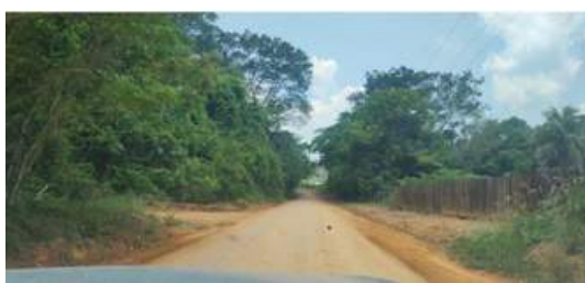
FIGURA 174 PRINCIPAL ESTRADA QUE DÁ ACESSO AS VICINAIS LIGADAS AS ALDEIAS. CAMPO DE OUTUBRO DE 2023.
