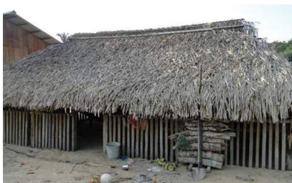
FIGURA 150 VISTA EXTERNA DE UMA COZINHA, ALDEIA RONKOJAGOT, EM 10/10/2023.
