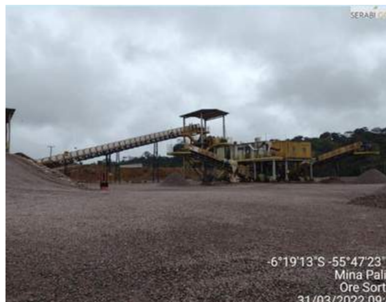
FIGURA20 VISTA FRONTAL DO ORE SORTER NA MINA DO PALITO.
