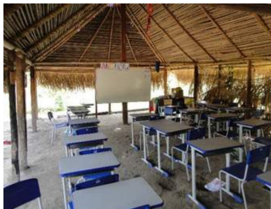
FIGURA 203 PARTE INTERNA DE UM TELHADO DE BABAÇU, ESCOLA DA ALDEIA KRAMBARJ, EM 09/10/23.
