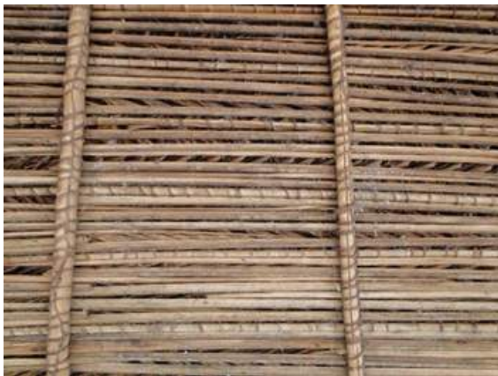
FIGURA 200 EMBIRAS UTILIZADAS NA AMARRAÇÃO DOS TELHADOS, ALDEIA RAMBARO, EM 10/23
