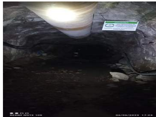
FIGURA 14 DUTOS DE VENTILAÇÃO.
