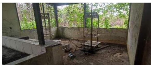
FIGURA 128 VISTA INTERNA DA CASA DE FARINHA, ALDEIA KAMAU, EM 06/10/2023.
