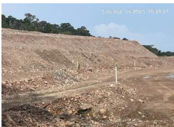
FIGURA 23 IMAGEM DE UM TALUDE DE UMA PILHA.
