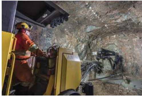
FIGURA 6 FUROS PARA COLOCAÇÃO DAS DINAMITES
