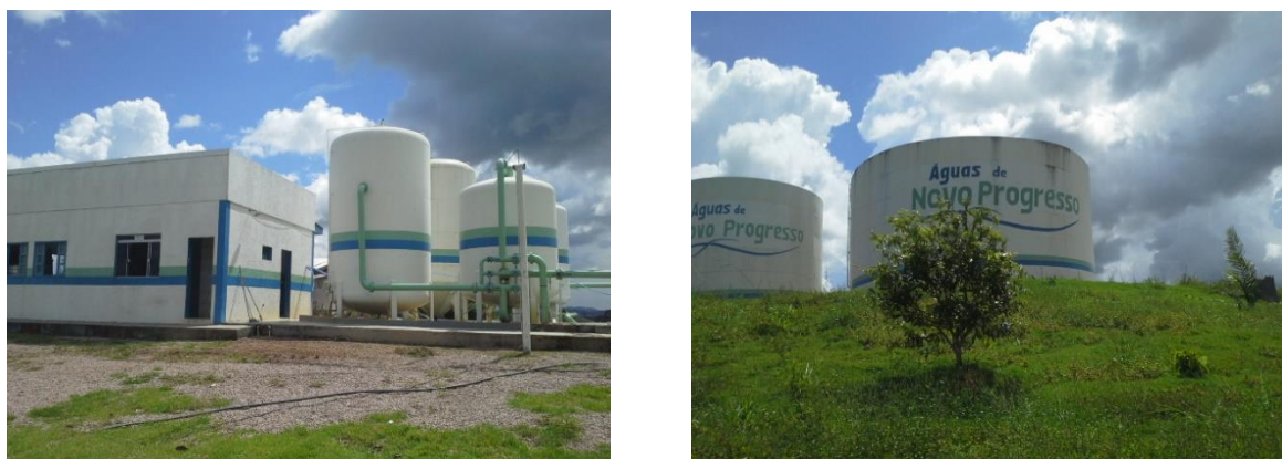
Figura 4.3-41 - Estação de Tratamento de Água de Novo Progresso.
