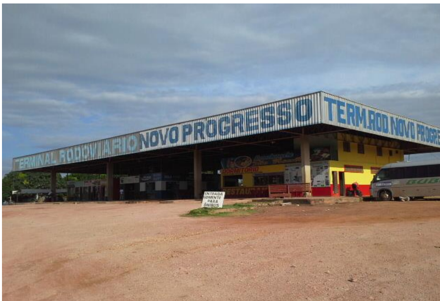
Figura 4.3-59 - Terminal Rodoviário de Novo Progresso.
