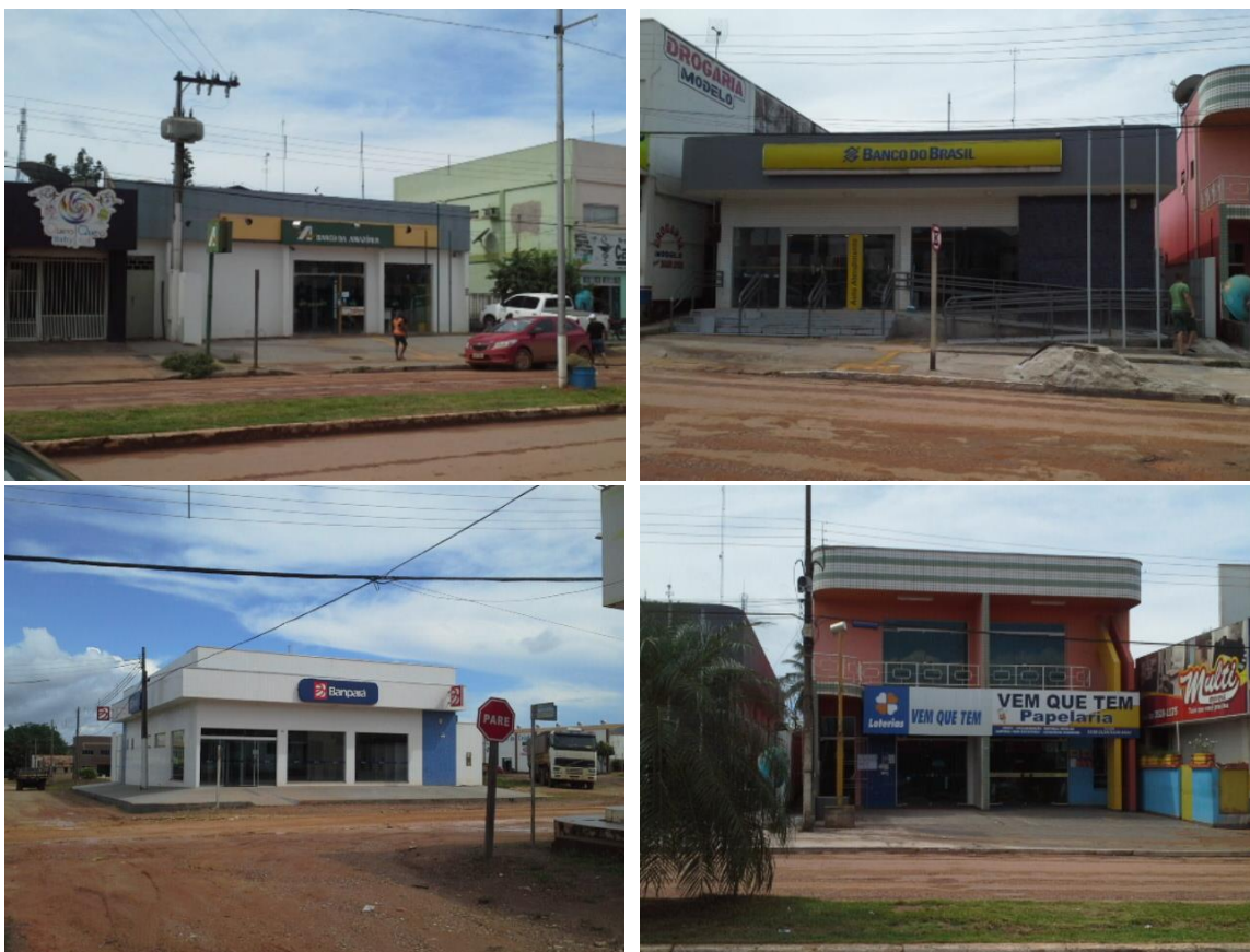
Figura 4.3-57 - Agências Bancárias no município de Novo Progresso.
