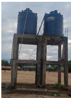
FIGURA 1079 POÇO ARTESIANO E CAIXAS D'ÁGUA, ALDEIA KAMAU , EM 05/10/2023.
