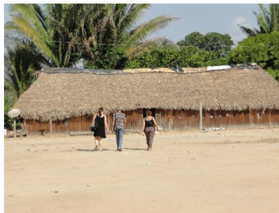
FIGURA 203 CASA TRADICIONAL CONSTRUÍDA COM MADEIRA E TELHADO COM FOLHAS DE BABAÇU, ALDEIA KAMAU, EM 06/10/23.
