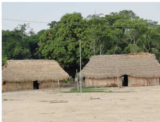
FIGURA 202 CASAS TRADICIONAIS, CONSTRUÍDAS COM MADEIRA E FOLHAS DE BABAÇU, ALDEIA BAÚ, EM 14/10/23.
