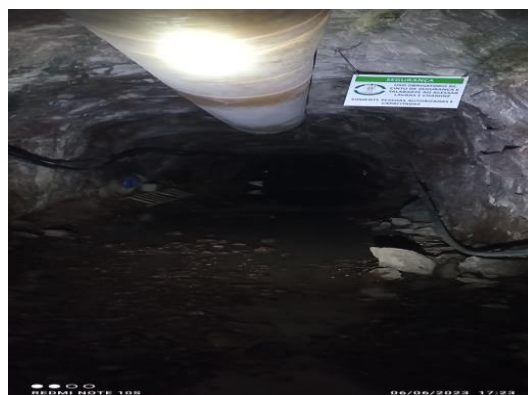
FIGURA 14 DUTOS DE VENTILAÇÃO.
