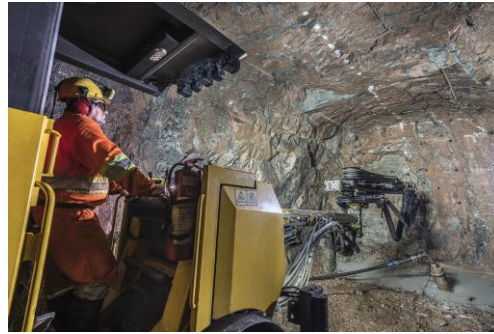
FIGURA 6 FUROS PARA COLOCAÇÃO DAS DINAMITES
