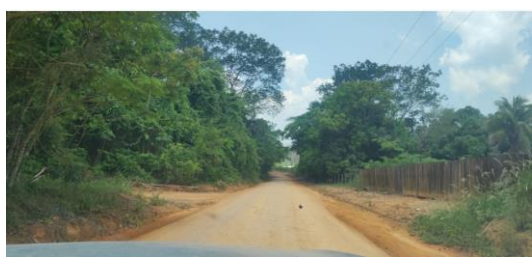
FIGURA 178 PRINCIPAL ESTRADA QUE DÁ ACESSO AS VICINAIS LIGADAS AS ALDEIAS. CAMPO DE OUTUBRO DE 2023.
