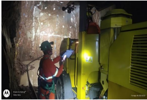
FIGURA 5 PREPARAÇÃO DE DETONAÇÃO.
