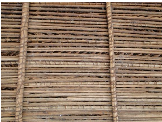
FIGURA 204 EMBIRAS UTILIZADAS NA AMARRAÇÃO DOS TELHADOS, ALDEIA KRAMBARJ, EM 09/10/23.
