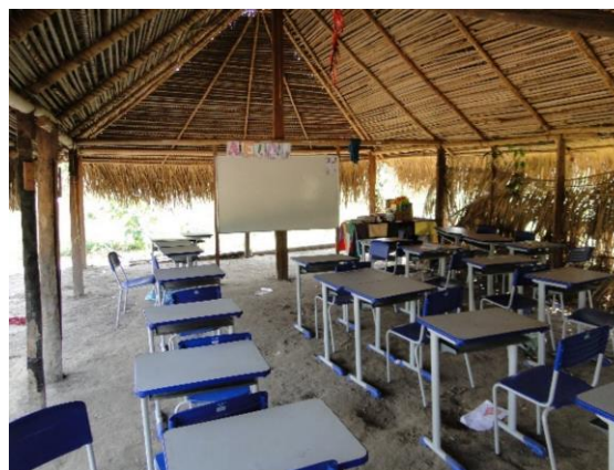
FIGURA 207 PARTE INTERNA DE UM TELHADO DE BABAÇU, ESCOLA DA ALDEIA KRAMBARJ, EM 09/10/23.
