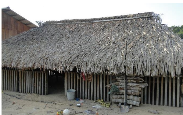
FIGURA 152 VISTA EXTERNA DE UMA COZINHA, ALDEIA RONKOJAGOT, EM 10/10/2023.
