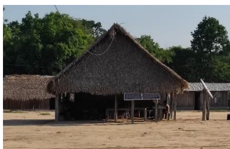
FIGURA 161 PLACA DE ENERGIA SOLAR, ANTENA PARABÓLICA, INTERNET, ALDEIA BAÚ, EM 13/10/2023.
