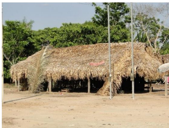
FIGURA 1286 TELHADO FEITO COM FOLHAS DE BABAÇU, ALDEIA KAMAU, EM 06/10/23.
