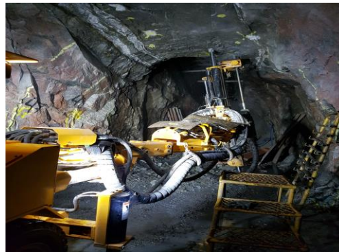
FIGURA 8 PREPARAÇÃO DE GALERIA.
