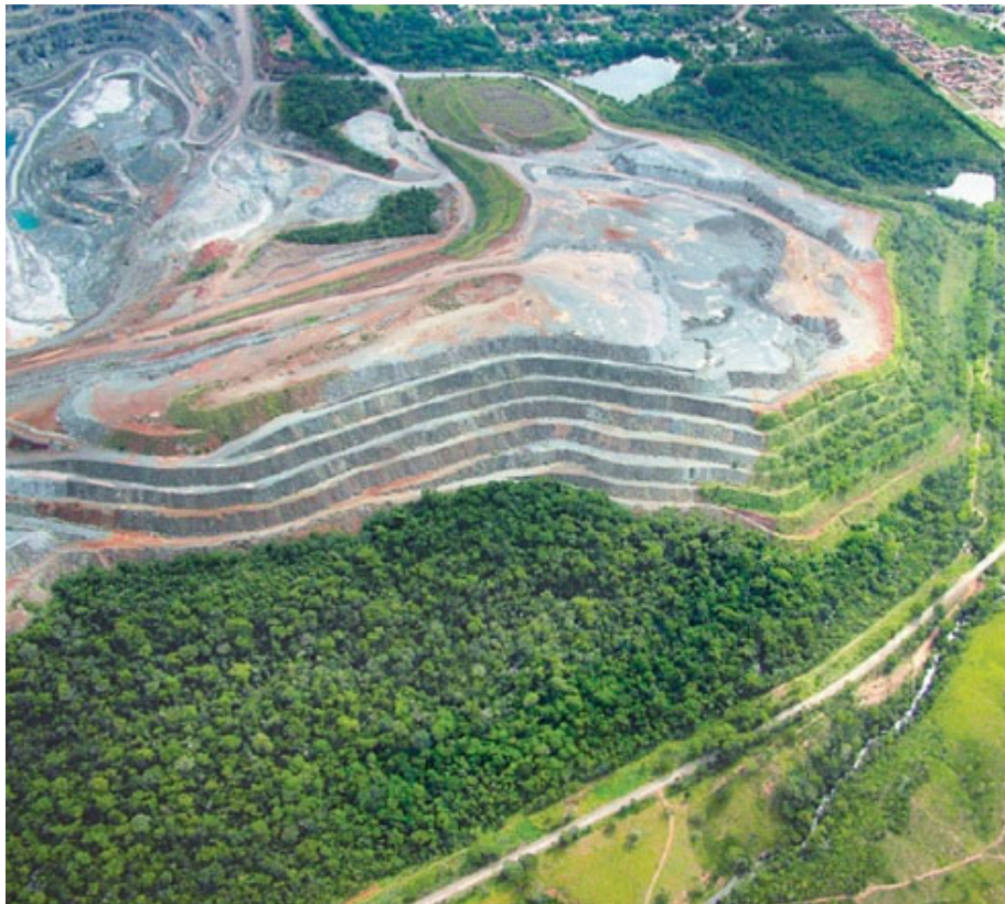
Figura 4.0.a Pilha de estéril em construção com revegetação simultânea em progresso nos bancos inferiores do lado direito
