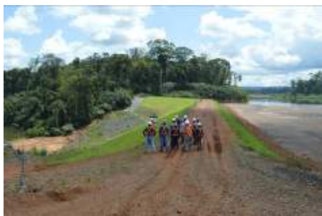
Foto 05: Visita à Mina Tucano – barragem de rejeitos (25/07/2019).
