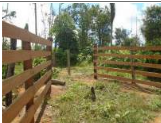
Foto 60: Curral sendo construído na Itkoum, durante a campanha de verão (15/07/19).
