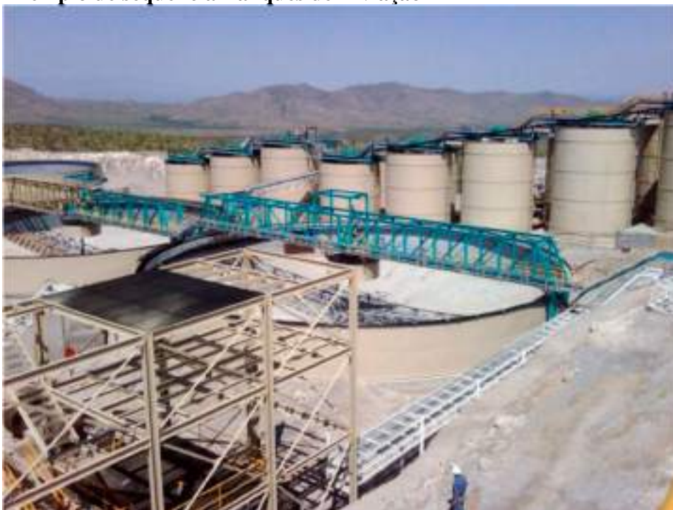
Figura 2.4.6.c Exemplo de sequencia Tanques de Lixiviação
