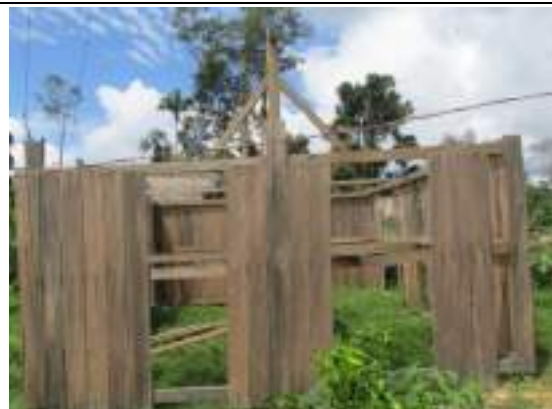
Foto 06: Farmácia em construção – aldeia Itkoum (26/01/19).
