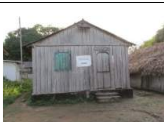
Foto 06: Sede da Associação AIRAM – aldeia Terrawangã (23/01/19).
