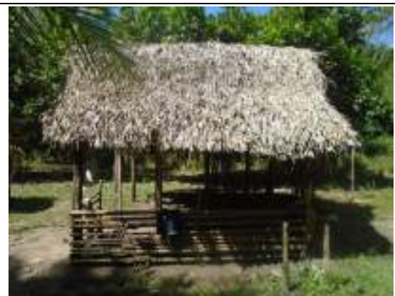
Foto 28: Barraco com cobertura de palha de babaçu no Cacoal do Zé Cotia (24/01/2019).
