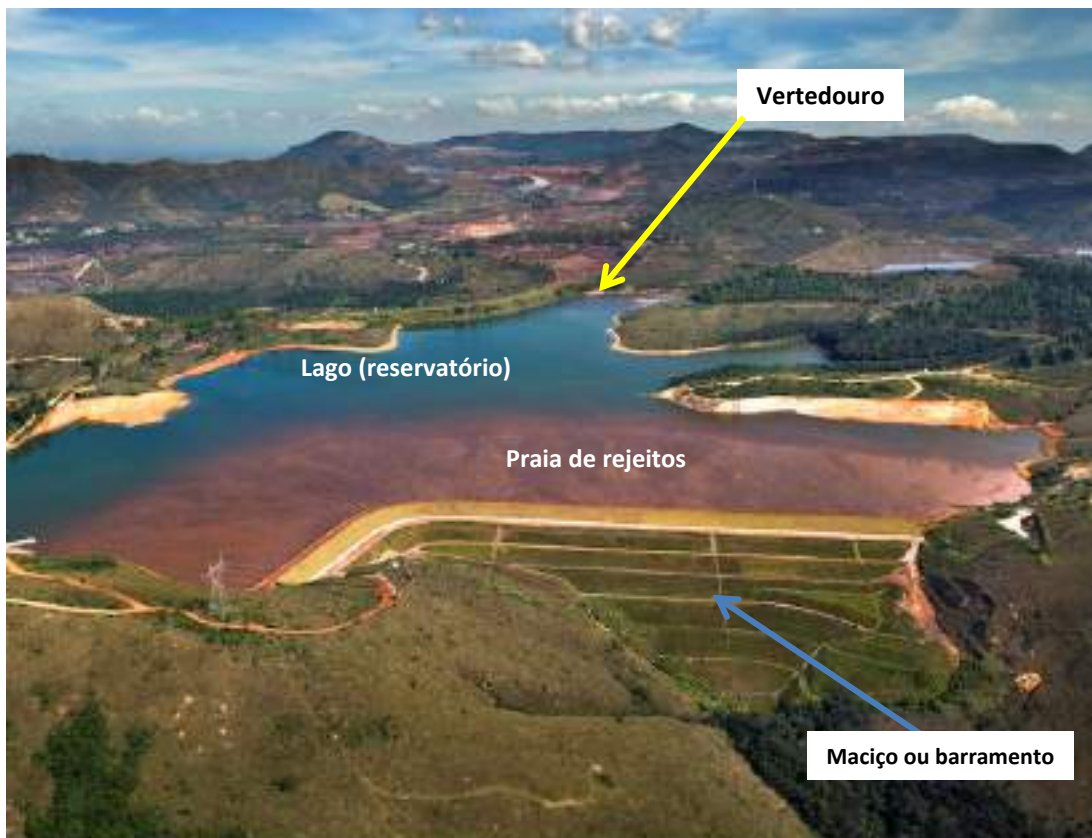
Figura 2.4.5.a Exemplo de barragem de rejeito
