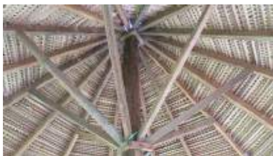
Foto 26: Estrutura da casa do guerreiro na aldeia Guary-Duan, feito de castanheira e olho da palha de babaçu.
