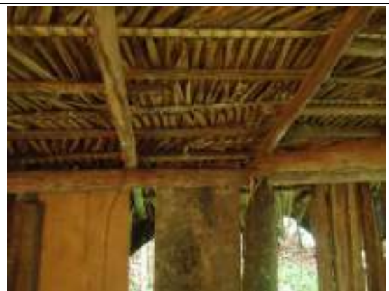
Foto 27: Palha braba de babaçu utilizada na cobertura de barraco no Cacoal do Seu Josias (24/01/2019).
