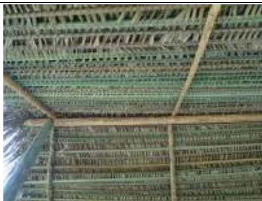
Foto 22: Casa de palha e madeira na Ilha de Serra (25/01/2019). Madeiras utilizadas são o ameju, acapu e envira-preta, com palha de Babaçu na cobertura.
