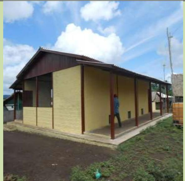
**Figura 00 – Fachada posterior com área para colocar lenha para os fornos, com cobertura baixa, as laterais não possuem cobertura.**
