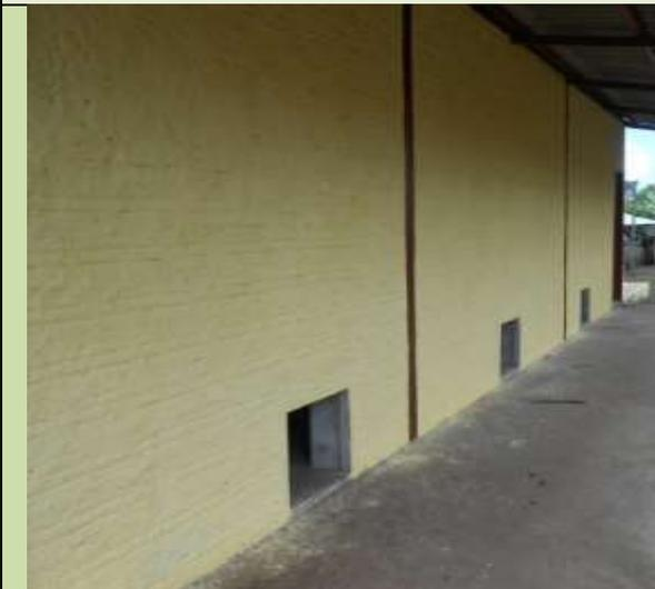
**Figura 00 – detalhe da área externa para alimentar os fornos com lenha, vãos em média de 60x45cm, sem portinholas ou chaminés, parede com chapisco e pintada.**
