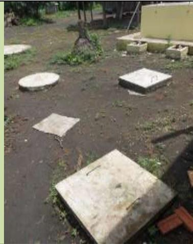
**Figura 00 – Placas em concreto armado de inspeção da rede (sumidouro e fossa).**
