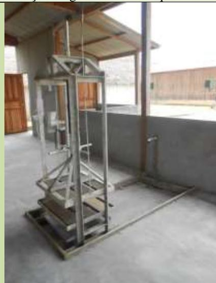
Figura 00 – Aldeia Djuruanti, área da pensa, vários tamanhos, diferentes do projeto, sem inclinação para escorrer a água.
