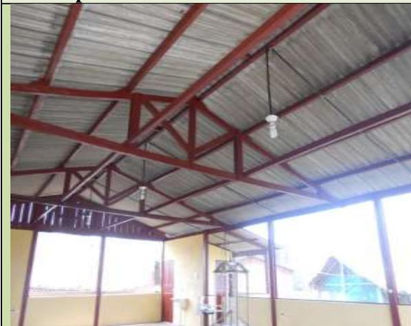
**Figura 00 – detalhe da cobertura em fibrocimento e dois pontos de iluminação**
