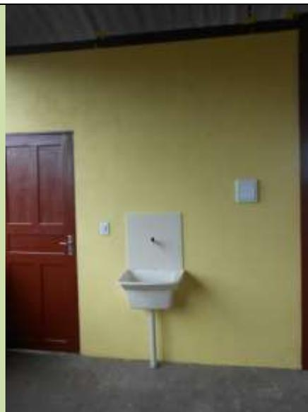
**Figura 00 – espaço destinado a Pia (com tubulação exposta), porta de acesso pintada, parede rebocada e pintada.**
