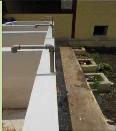
**Figura 00 – detalhe de área externa com o pubeiro, tubulação frágil e exposta ao sol, o pubeiro contém quatro divisões, revestidos internamente com cerâmica, os “cantos” internos também deveriam ser curvos e não retos. Facilitando a limpeza.**
