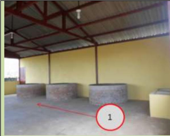
**Figura 00 – área interna, com detalhe dos fornos e cocho, observar a distancia de acesso para o forno n°01.**
