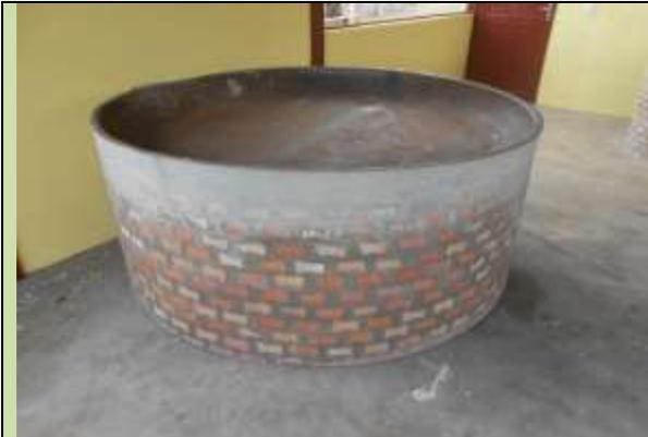
**Figura 00 – Detalhe do Forno, nesta casa observa-se a utilização do tijolo refratário.**
