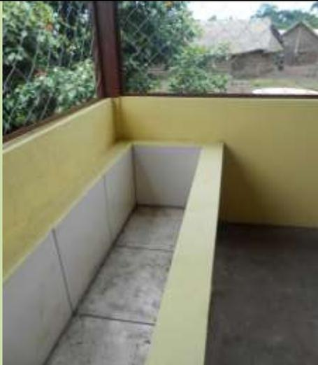
**Figura 00 – Cocho revestido em cerâmica, o mesmo deveria conter uma concavidade (formato curvo em “U”) para facilitar a limpeza. Sem a cobertura externa o cocho recebe sol e chuva.**
