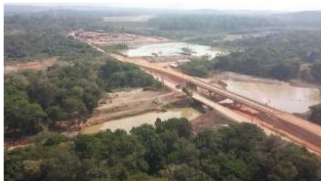
Foto 11: Ponte Avenida Tancredo Neves
