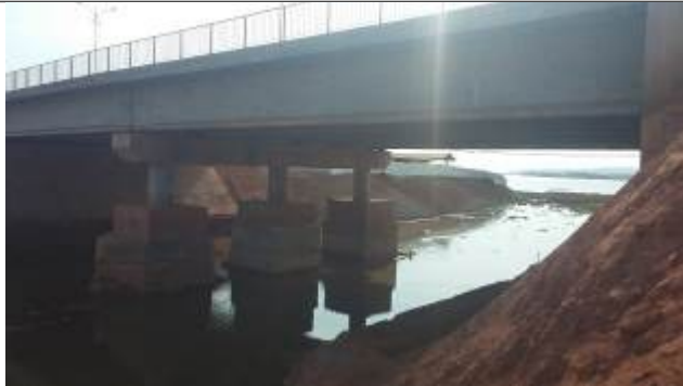
Foto: 05 Ponte Coronel José Porfírio
