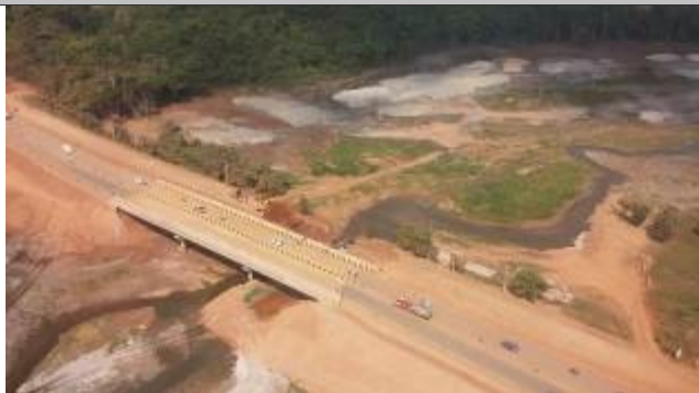
Foto 09: Ponte Rodovia Ernesto Alcicoli
