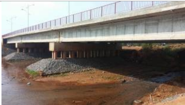
Foto 07: Ponte Rua Goldim Lins
