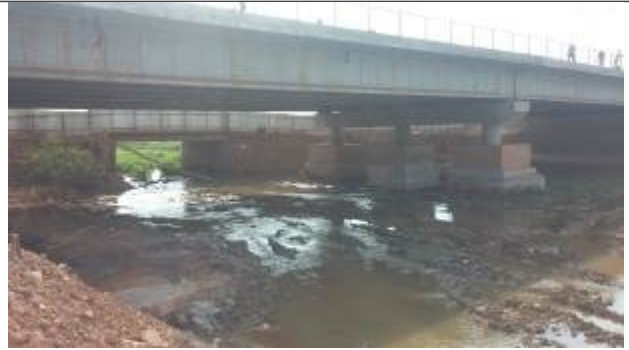
Foto 06: Ponte Rua João Coelho
