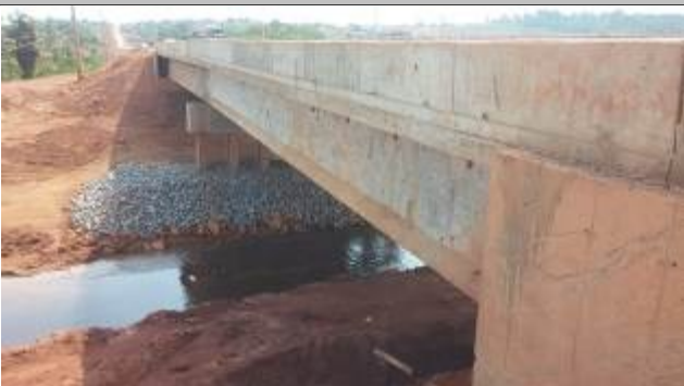
Foto 10: Ponte Rodovia Transamazônica (Ambé)
