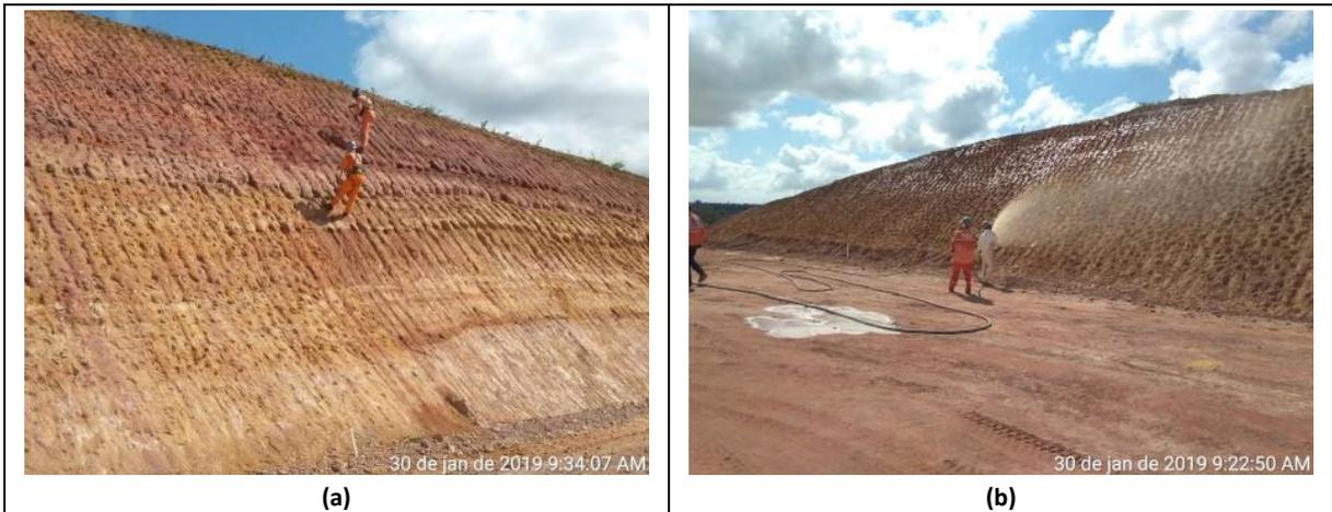
**Figura 16 - Hidrossemeadura realizada em taludes (arquivo MRS, 2019). (a) Escarificação do talude para acomodação da semente. (b) Semeadura com jato de alta pressão.**
